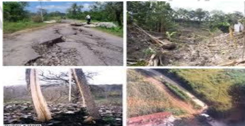
Gambar.1.2. Kerusakan akibat gempa bumi
