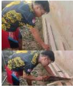
Gambar 2.16 Pengukuran Dan Pemetongan Kayu
